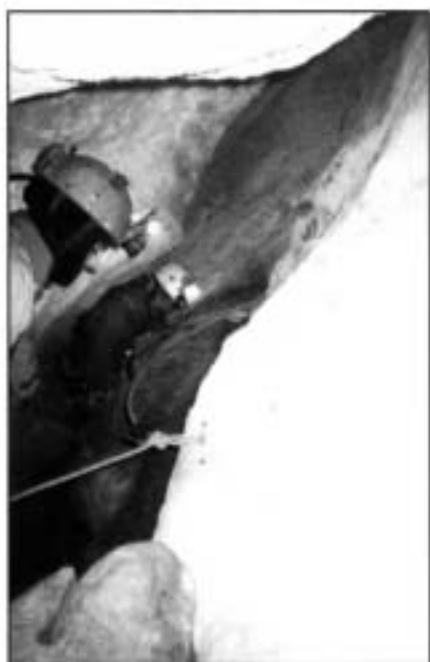
Instal·lant un pou. Foto: Toni Muela
