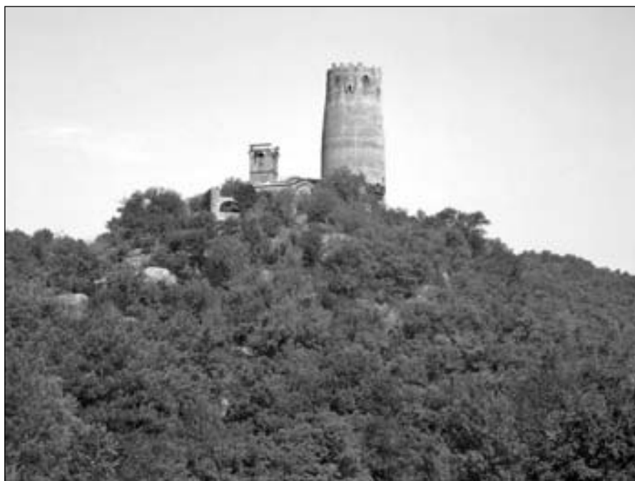
Vallferosa, conjunt d'església i torre, des de Can Trena. Foto: Salvador Butí
