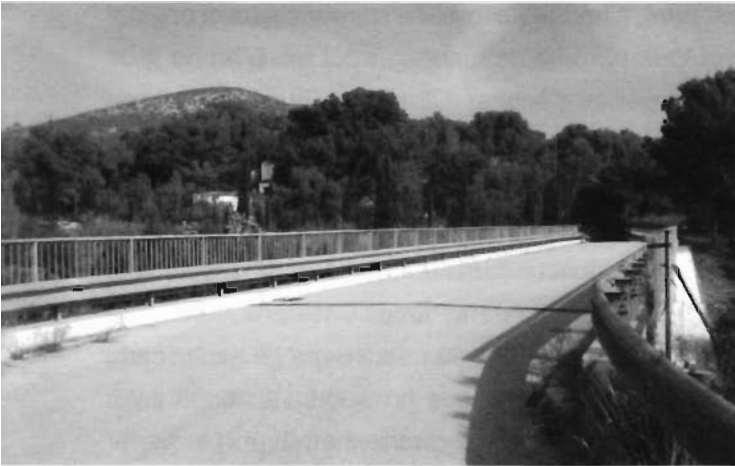
Pont sobre l'autopista Pau Casals
