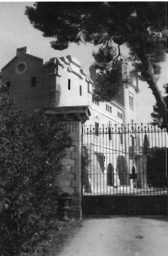
Torre del Veguer
