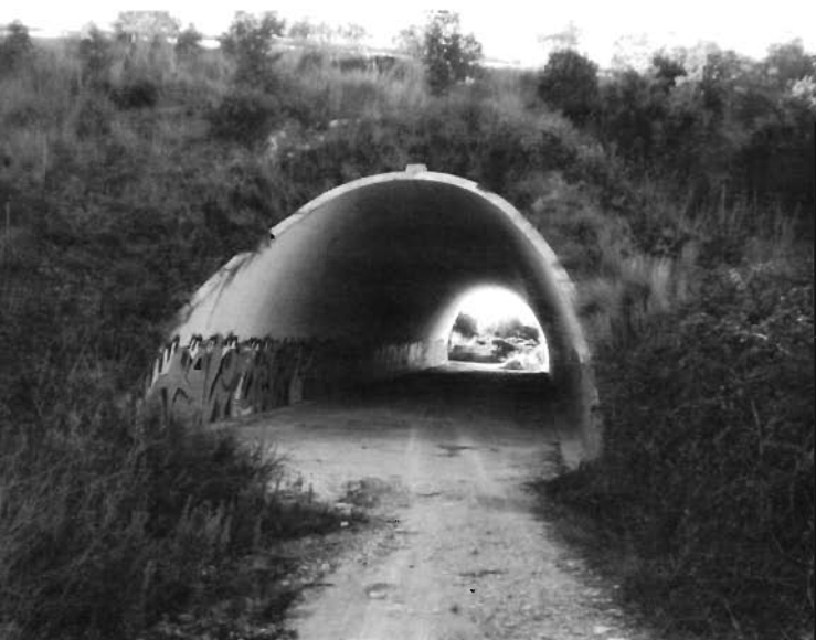
Túnel sota l'autopista
