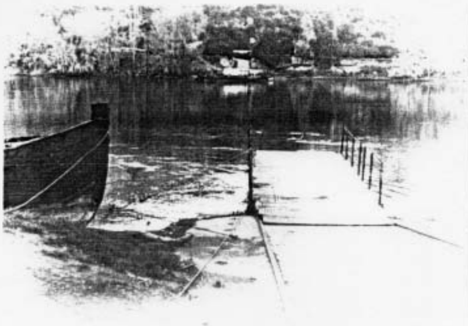
PLATAFORMA DE PUJADA AL TRANSBORDADOR O BARCASSA PER A PODER TRASPASSAR EL RIU
