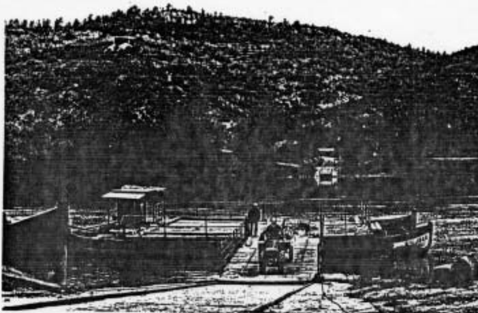
BENIFALLET SISTEMA DE COMUNICACIÓ ENTRE LES DUES RIBES DEL RIU
