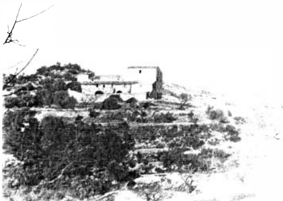
MAS DE L'ANDREU, EDIFICI DE TRES PISOS D'ALÇADA
