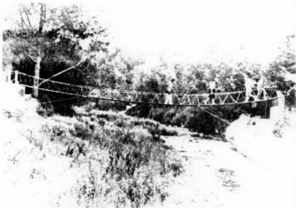
PONT SUSPÈS SOBRE EL RIU BRUGENT
