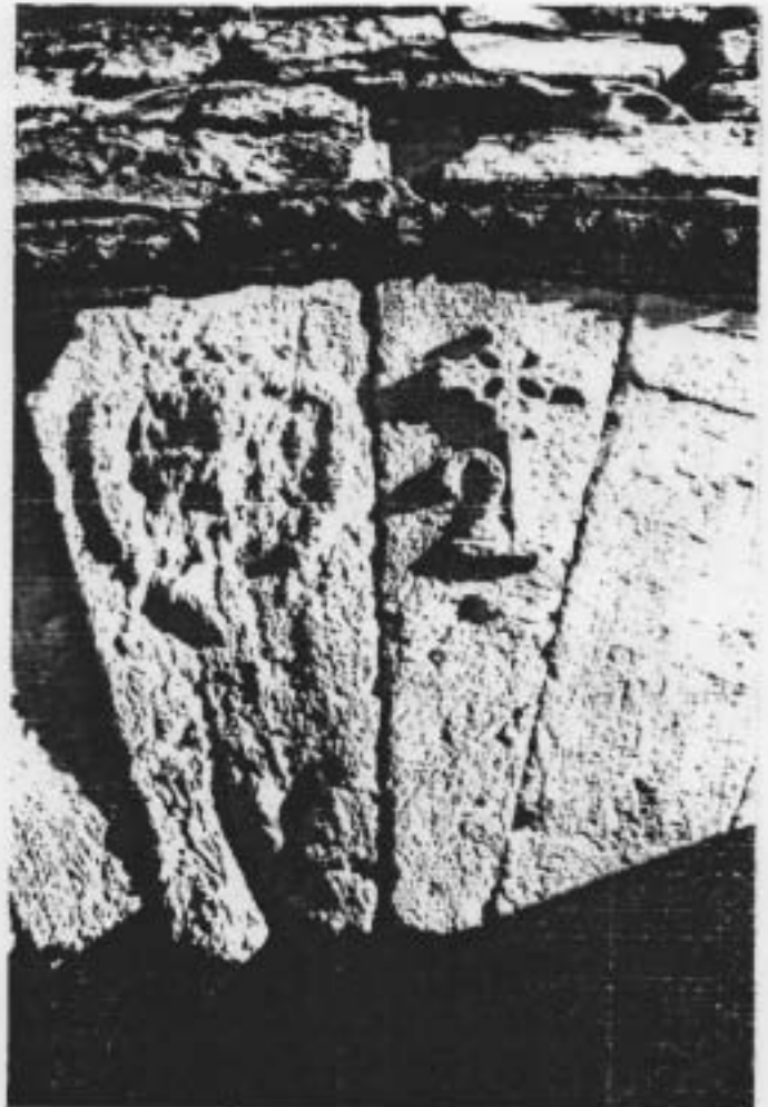
ESCUT I CIAU AMB UN ALT RELLEU MOLT DETERIORAT
