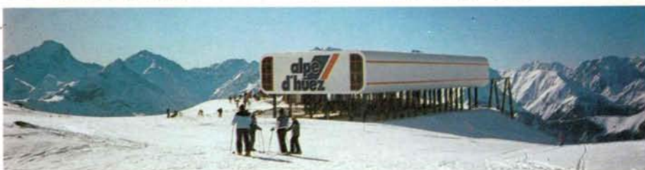
Noves instal·lacions del telecabina de Les Marmottes, al sector de Les Grandes Rousses
