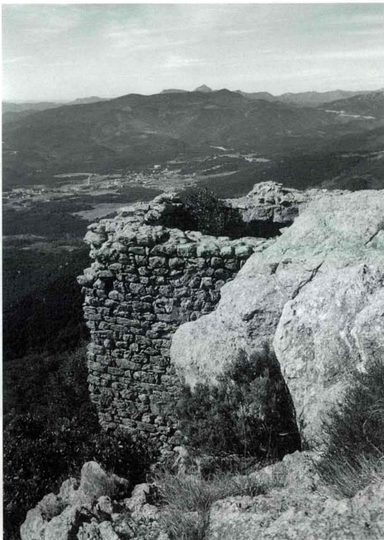
La torre cisterna del castell de Cabrera, amb la vall de Maçanet de Cabrenys al fons.
