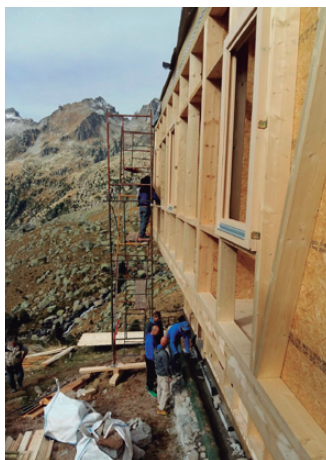
La construcció d'un mòdul de fusta prefabricat, folrat amb xapa i policarbonat, forma part de la primera fase de les obres.
