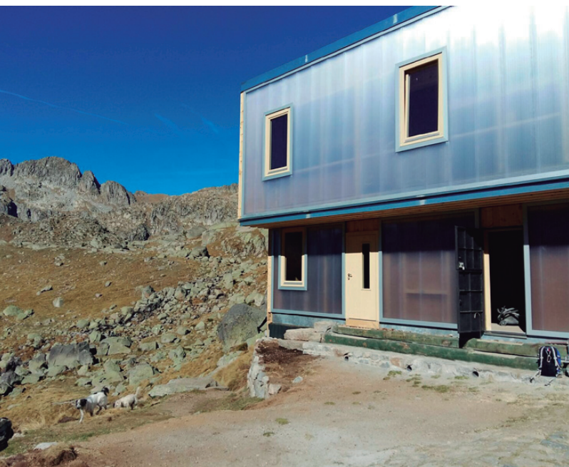
La construcció d'un mòdul de fusta prefabricat, folrat amb xapa i policarbonat, forma part de la primera fase de les obres.
