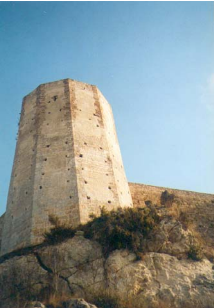
Imposant torre de l'homenatge, de planta decagonal, element característic d'aquest castell. Fotografia de Josep Arisa
