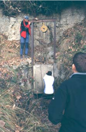
Pujant la llosa d'entrada amb el tràctel. Foto de Cristina Xifra
