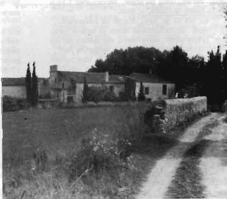
Can Girona del Camí - Vista general
