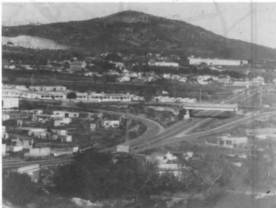
Enllaç amb la carretera de l'Arbog des de la Collada (Foto: J. Virella)
