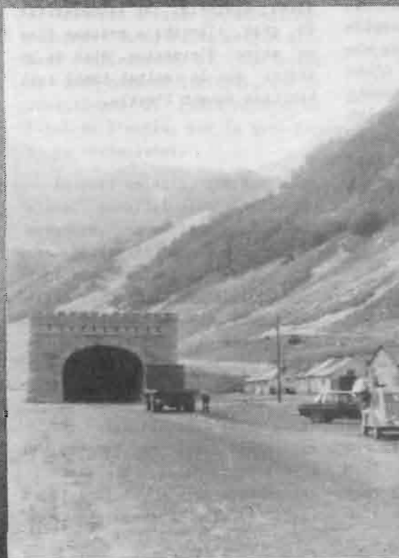
Boca Sud del Túnel de Viella (Foto: Josep Blanes)
