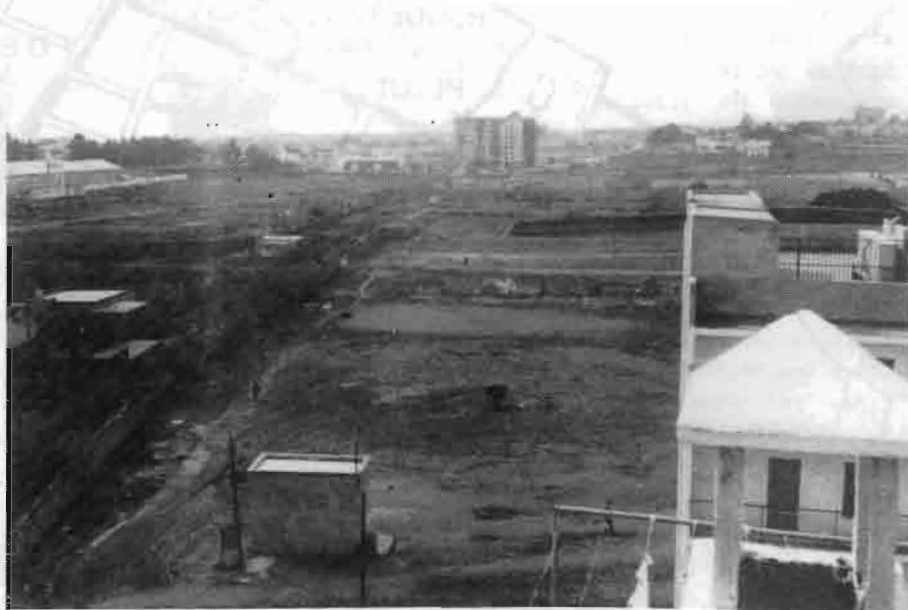
Solar de la Plaça Xoriguer i Camí de les Roques del Pelut (1968). (Foto J. Virella)
