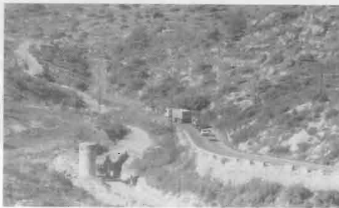
Començament de les obres de remodelació de la Pujada de Canyelles (30.7.90) Foto: Toni Sagarra
