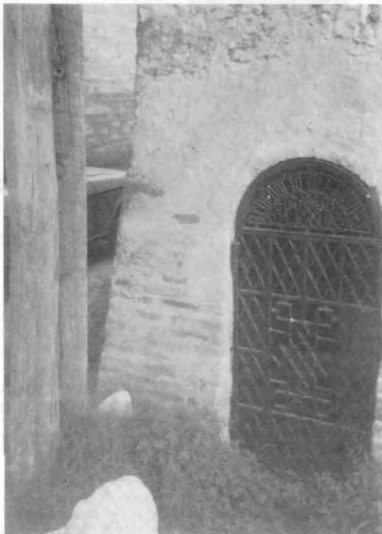
Porta de ferro forjat al sobreeixidor del dipòsit de la Collada (Foto: J. Sivill)
