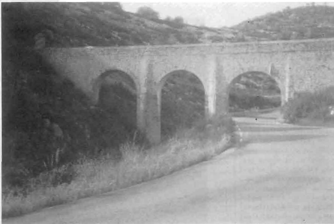
Aqüeducte d'abastament d'aigua a Vilanova creuant la carretera de l'Arbog (Foto. J. Sivill)
