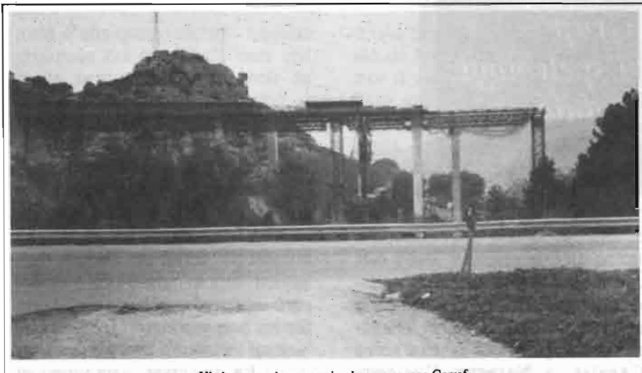
Viaducte a mig construir al seu pas per Garraf amb el Castellet al fons. Foto: Miquel Galmes
