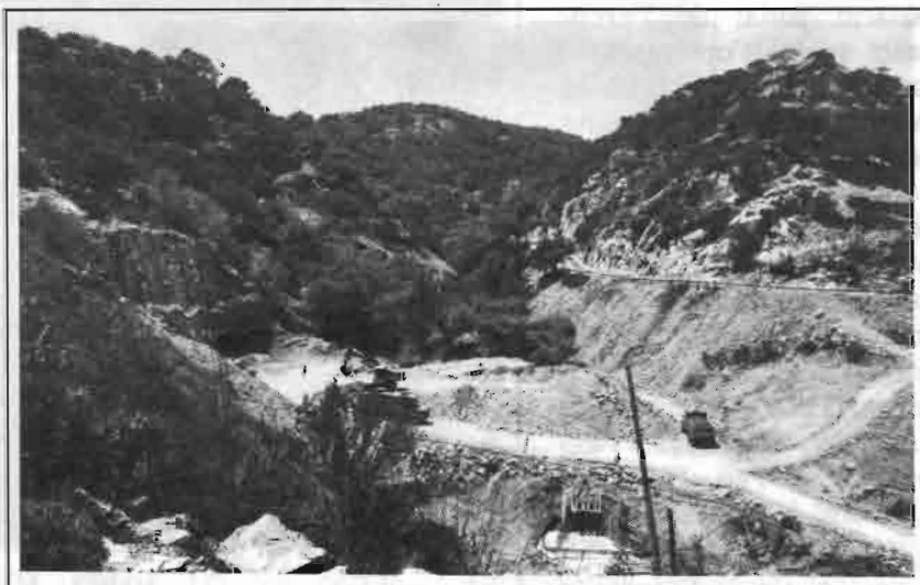
Començament del forat d'un dels túnels a la Riera Falconera. Foto: Miquel Galmes
