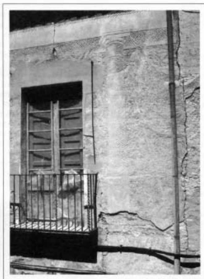
Alguns esgrafiats amb columnes toscanes i garlandes de la façana oest. Foto: R. Farriol
