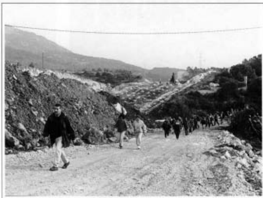
Prop del Corral de Carro, ens dirigim cap a les obres de l'autopista per travessar-les. Foto: F. Casas
