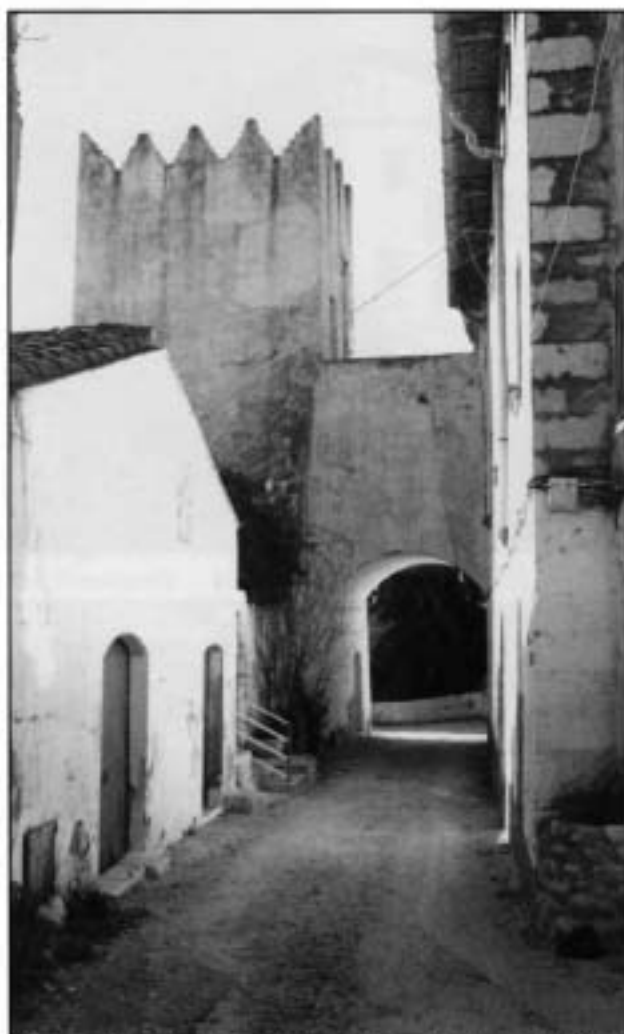
Vilanova. Can Vidal i el pont que l'uneix a la torre de defensa. Foto: Casas
