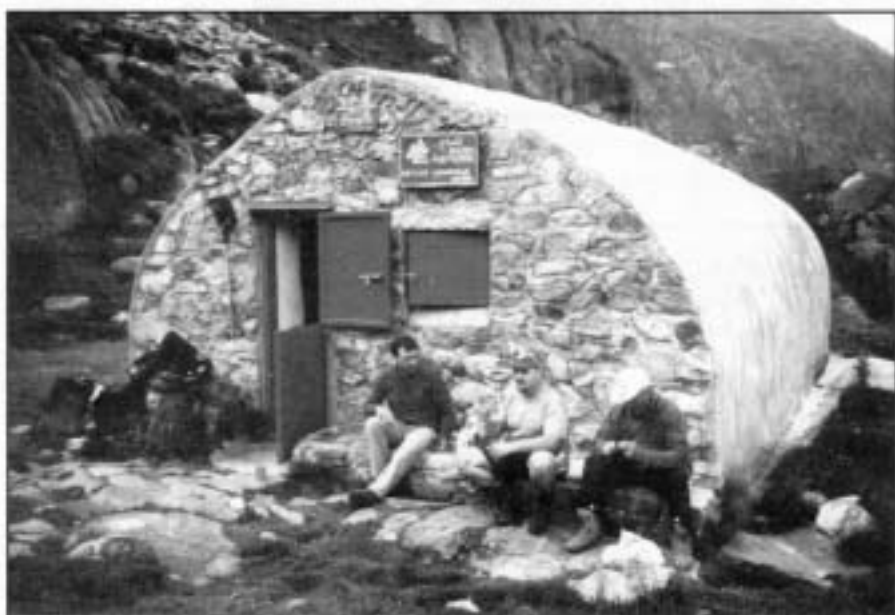
Refugi Ledormeur, situat a 1.920 metres d'alçada. Foto: Carles González
