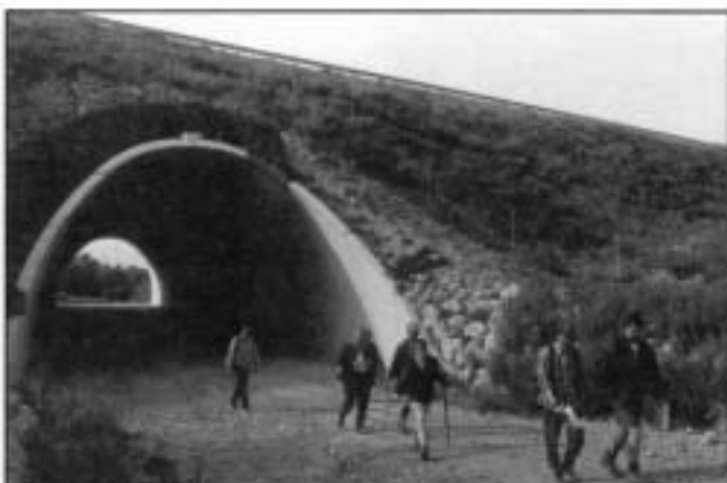
Pont de l'autopista. Foto: F. Casas
