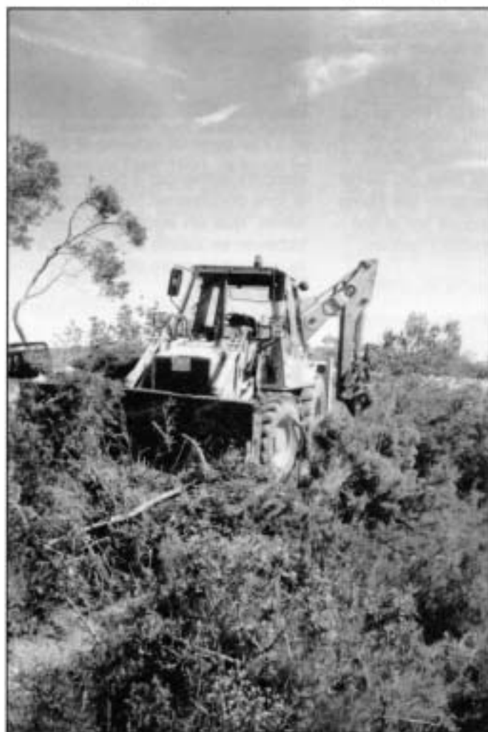
Una excavadora en plena Talaia. Foto: Jaume Soler
