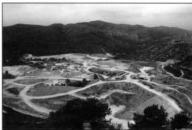
Pedra de la fàbrica de ciment de Valcarlos. Foto: F. Casas
