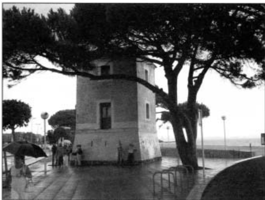
La torre de la platja de l'Esquirol. Foto: Mariona Siches
