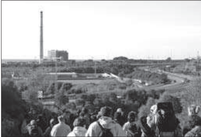
Panoràmica de la Central Tèrmica de Cubelles. Foto: Josep Blanes
