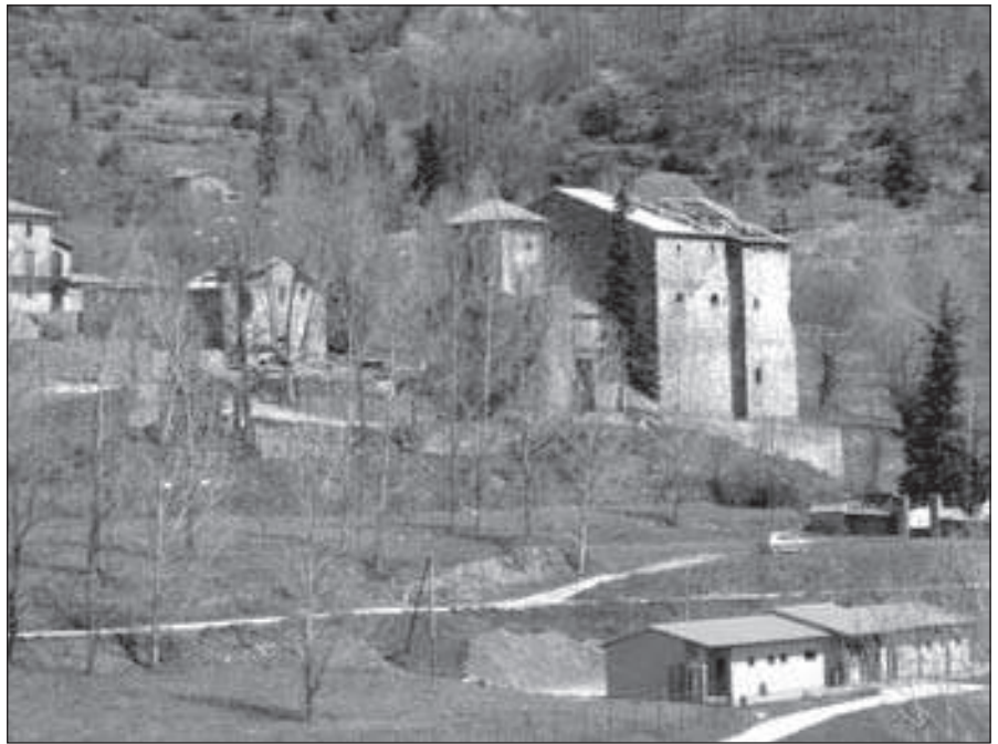
El Castell o la Sala de Vallfogona de Ripollès. Foto: Agustí Poch
