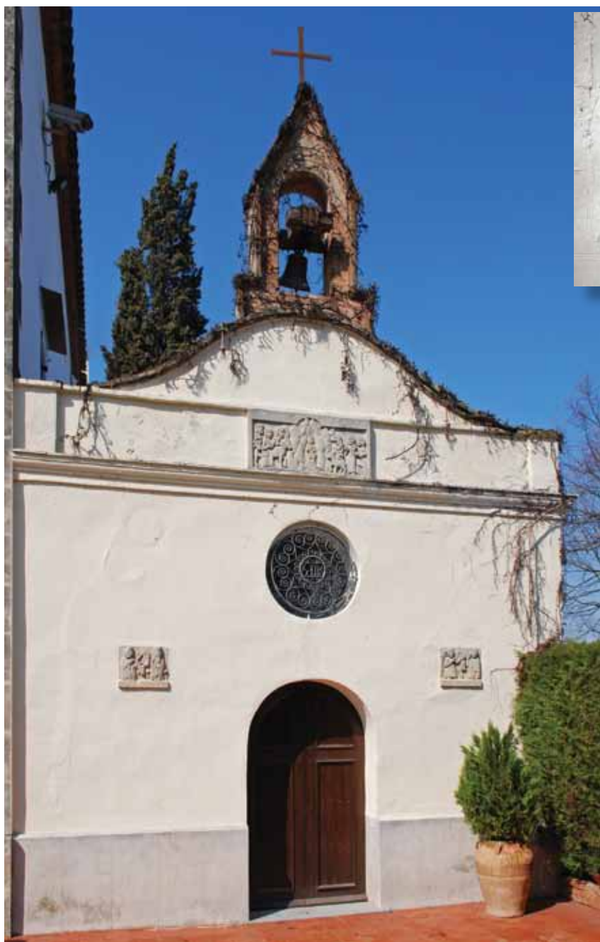
Molí Coloma.- Façana de la capella actualment
