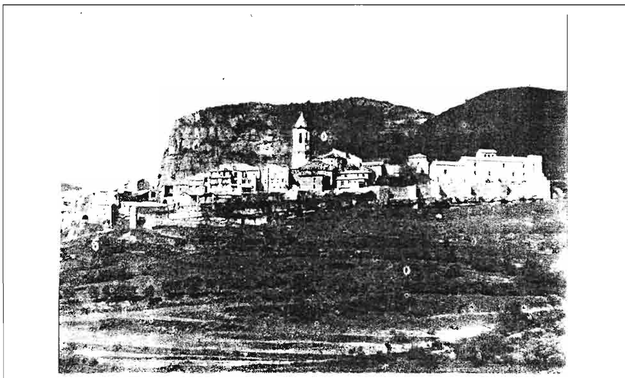
Roda de Isàvena. Vista general. Foto Arxlu.
