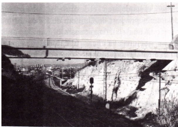
Pont de Sant Cristòfol, 1983.
