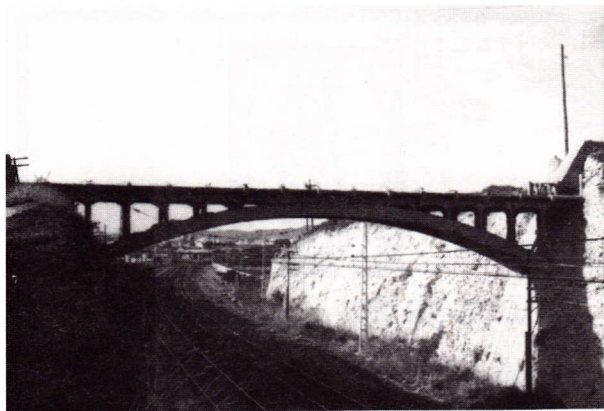
Pont de Sant Cristòfol, 1968.
