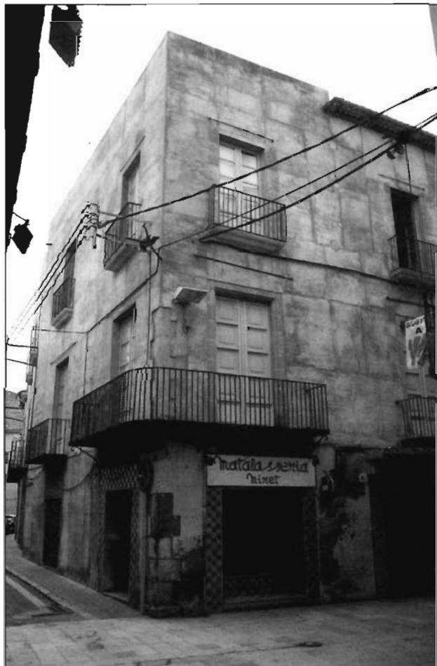
Edifici de la Talaia (casa Coloma). 2001. Foto: V. Carbonell
