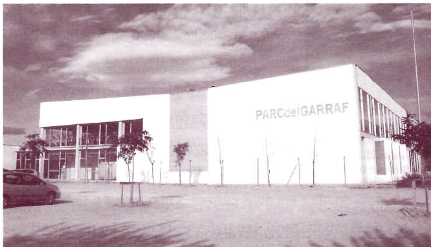
Instal·lacions del Parc del Garraf. 2005
