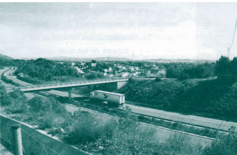
Pont del camí de la Talaia sobre l'autopista. Foto: Jesús Santacana 2006
