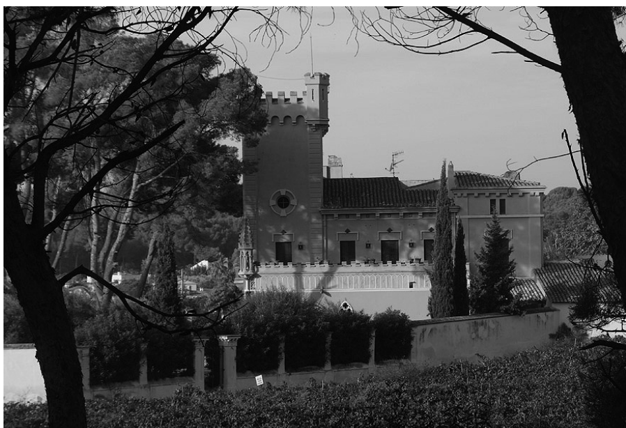
Torre del Veguer
