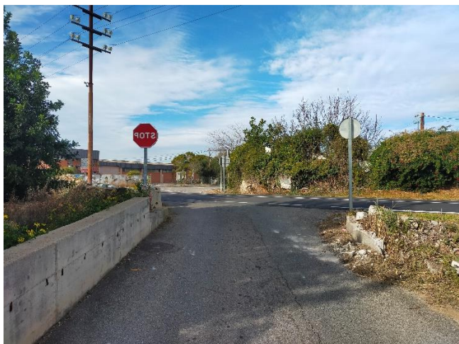
Carrer de la Turbina amb carretera de l'Arboç, 2024. Foto: J. Corella
