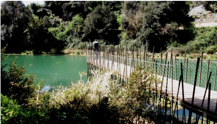
Passarel·la instal·lada sobre el pantà de Vallvidrera.
