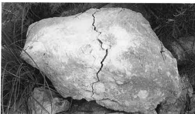
Vint hores després d'omplir el forat amb ciment expansiu aquest ja havia actuat, fracturant el bloc.
