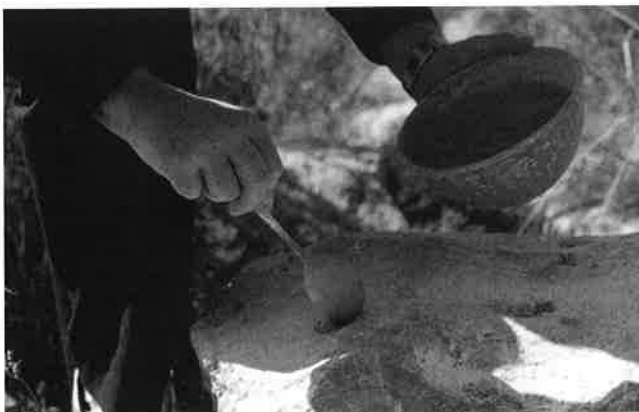
Omplint un forat amb ciment expansiu pel primitiu mètode de la cullera.
