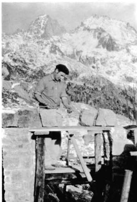
Treballs de construcció del nou refugi.
