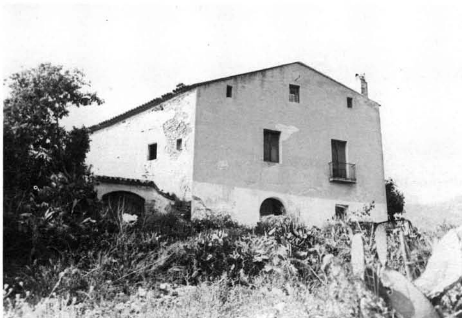
Façana de Torre Abadal completament restaurada a base de totxanes i ciment. Hom veurà que la xemeneia ha entrat en aquesta nova construcció, la qual no té res a veure amb l'antic mas. Al costat, hi ha el portal del pati que malgrat l'aparent estat de conservació, està completament abandonat i enrunat i, a més a més, és de difícil accés pel pedruscall i el creixement anàrquic de la bardissa.
