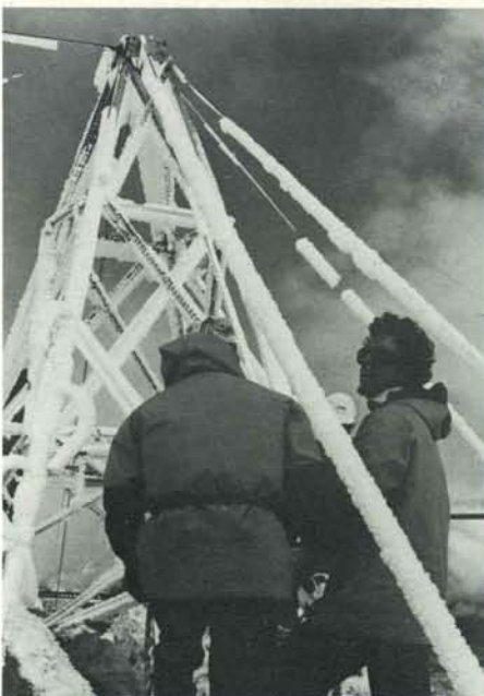
Tots els matins calia treure el glaç que bloquejava el funcionament del telefèric. (Foto: J. Altadill.)
