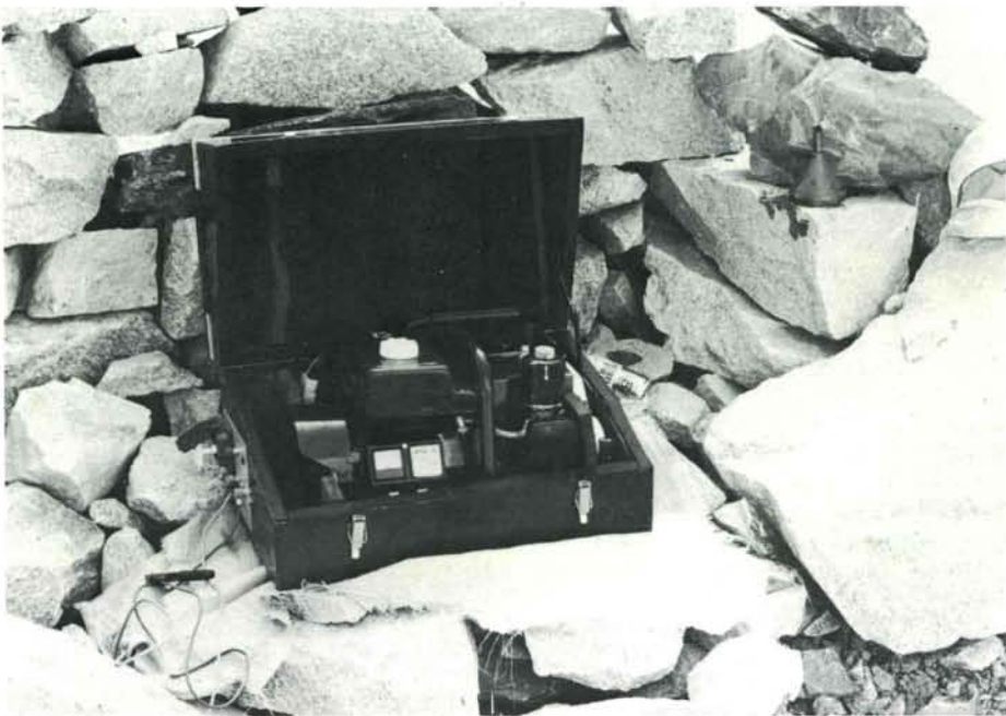
El nostre generador de corrent Mase amb el qual recarregarem les bateries. (Foto: J.M. Anglada.)
