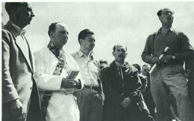
Nou xalet d'Ulldeter. Cerimònia de la primera pedra. D'esquerra a dreta: Lluís de Quadras, president, el senyor rector de Selcases, Eugeni Rosich, arquitecte, Josep Surinyach, constructor i Josep Ventosa, secretari. (Foto: Ramon Pujol.)
