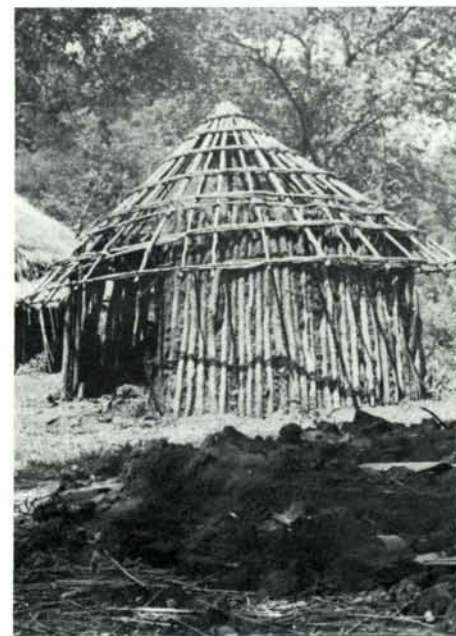
Cabana en construcció. A terra, argila per cobrir-ne l'estacada.
