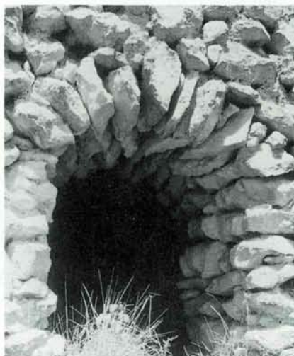
Detall d'un portal en forma d'arc apuntat. Noteu l'amplada de la paret i la forma i la disposició de les pedres, especialment la dovella-clau. Foto: Carolina Riba.
