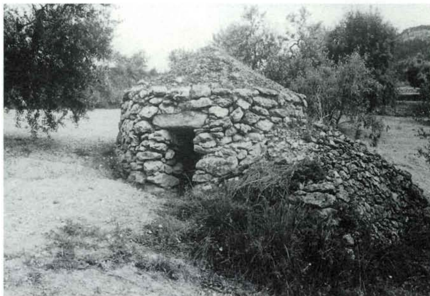
La Pobla de Claramunt, Anoia. Barraca anomenada del Sabater. Planta circular perfecta, amb volta cònica, recoberta de terra argilosa colonitzada per molses. Mida mitjana, situada al mig d'un camp d'oliveres i ametllers. Ben conservada. Pedra calcària sedimentària i carregada de fòssils, ennegrida per líquens, ja que en aquesta zona són freqüents les boires matinals que donen molta humitat. Portal rectangular format amb tres grans llandes iguals, vermelloses, provinents d'una beta triàssica, que hi ha a l'indret. En un costat s'apilen les pedres que es van traient del tros. Foto: Carolina Riba.
