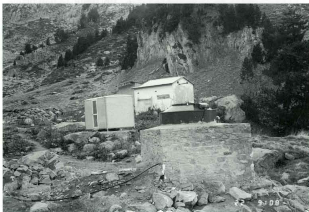
La depuradora d'aigües residuals i la caseta provisional dels sanitaris, l'octubre de 1997.
