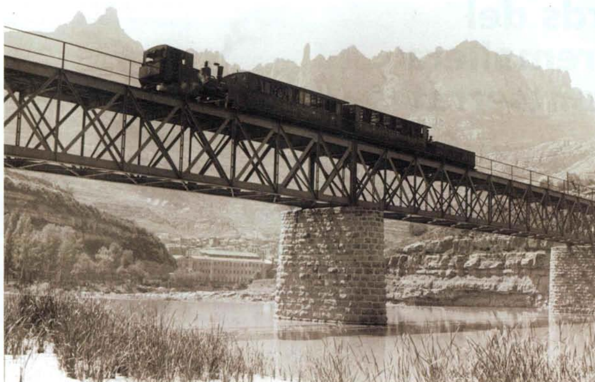
Un comboi del cremallera format per la locomotora, dos vagons de passatgers i un vagó de càrrega de baranes baixes, travessa el riu Llobregat per un pont, del qual actualment només podem veure els pilars.
