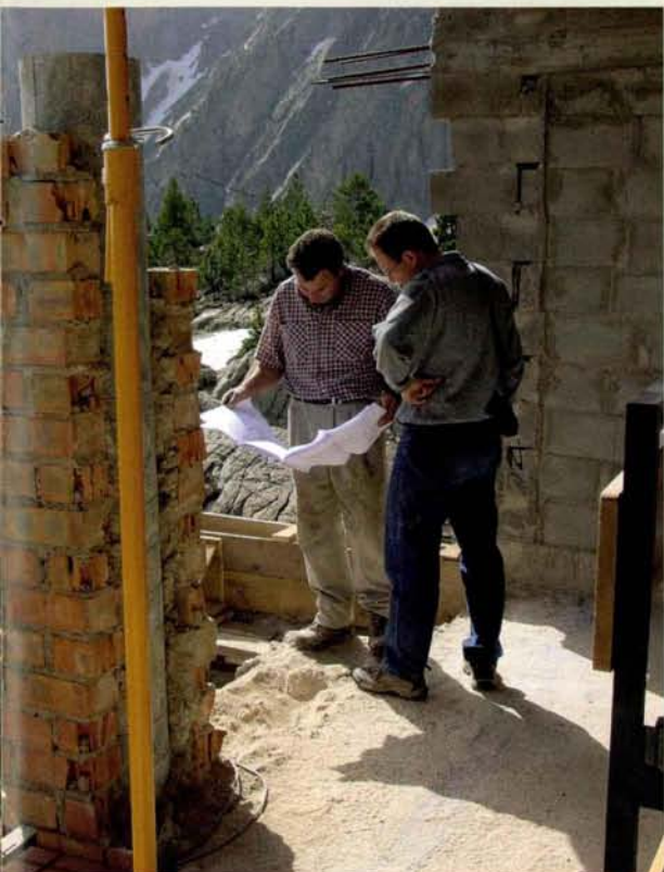
L'arquitecte Joan Barceló (d'esquena), repassa els darrers detalls amb el constructor, Gabriel Lamora.
