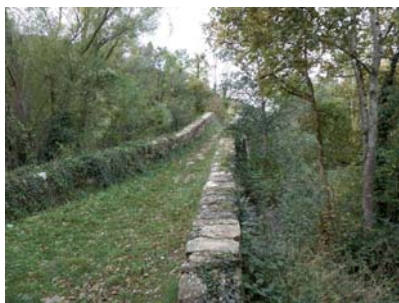
Pont sobre la riera
