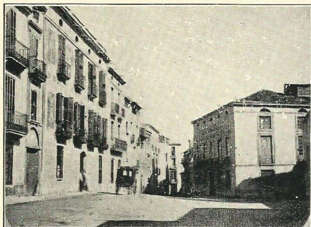
Façana de la casa Gali del Raval.
