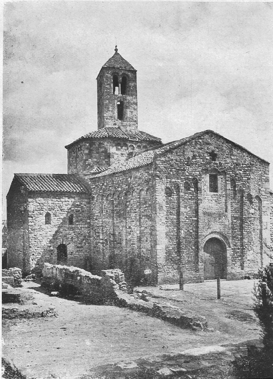
Fachada de la Iglesia de Santa María
